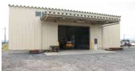
新設された資材倉庫
