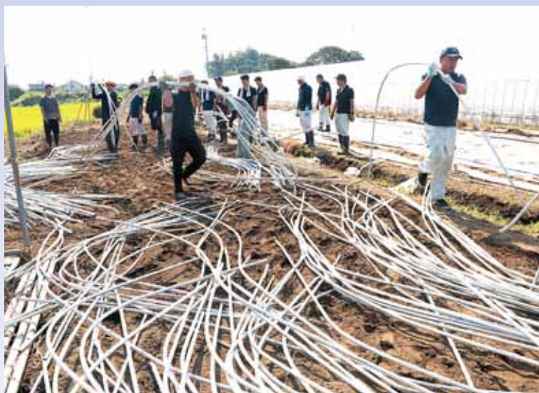
解体したハウスの骨組みを運ぶJA職員ら
