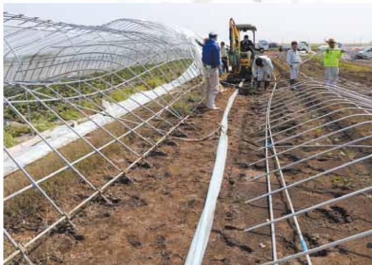
JAしもつけ管内でも、大平地区でイチゴハウス4棟が突風により倒壊。事態を受けて、JAでは速やかに、営農経済部や各地区営農経済センター職員による人的支援の準備を開始。災害発生2日後の15日にJA職員・大平町苺生産出荷組合所属の生産者ら約30人が駆けつけ、被災ハウスの解体・撤去作業に臨みました。
