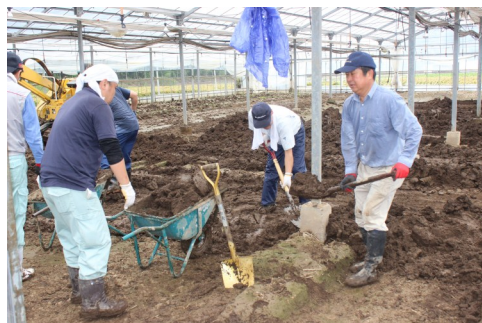
イチゴハウスの復旧作業に参加したJAグループ職員。ハウス内に流れ込んだ土砂の排出作業に当たった。
