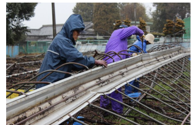
ブドウハウス再建に向けた解体作業を行うJA職員
