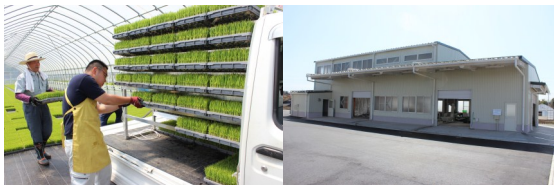
平成25年3月に竣工した北部水稻育苗センター
