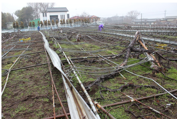
2月の大雪で倒壊したブドウのハウスとブドウ樹
