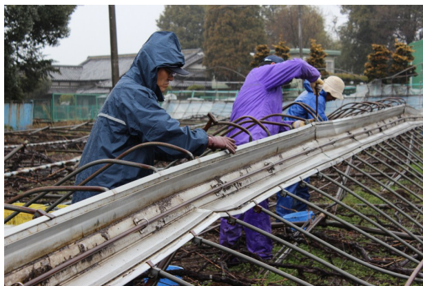
ブドウハウスの再建に向けた解体作業を行う J A 職員
