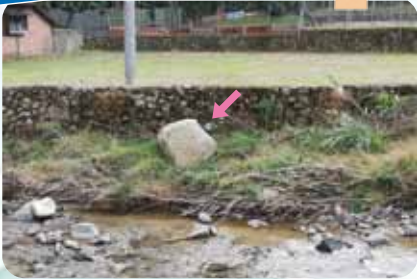
写真(1) 福岡県朝倉市
